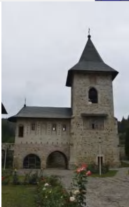
Fig. 58 Turn clopotniță cu Paraclisul "Sf. Ioan cel Nou"
