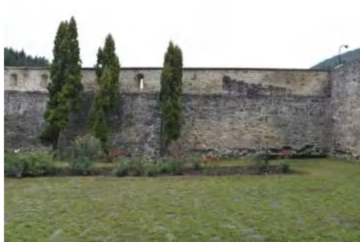
Fig. 61 Zid de incintă Mănăstirea Bistrița
